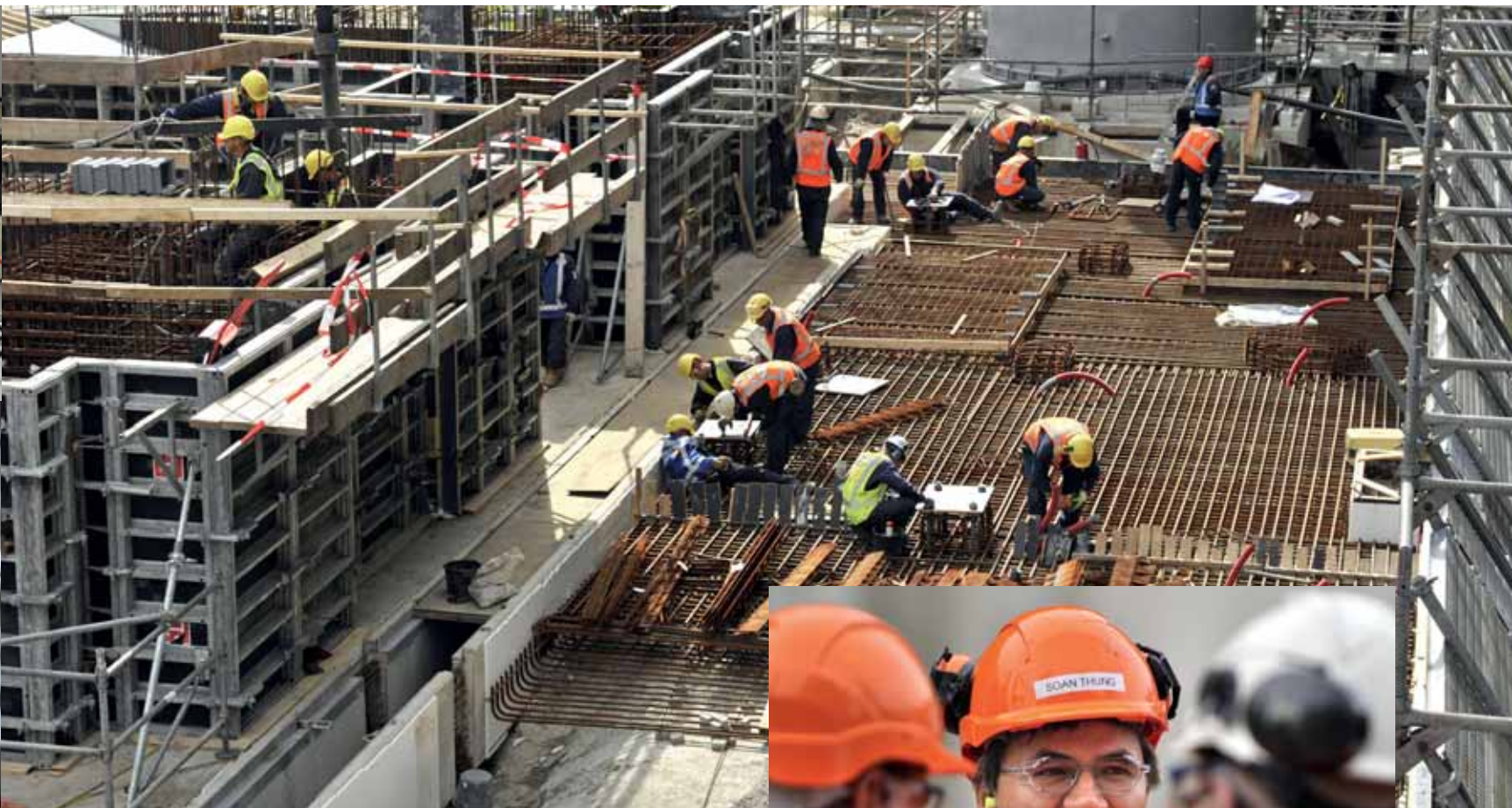
De ontzwavelingsfabriek in aanbouw.
